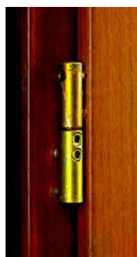
Fiche à réglages tri-directionnels
