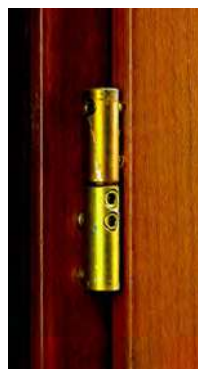
Fiche à réglages tri-directionnels
